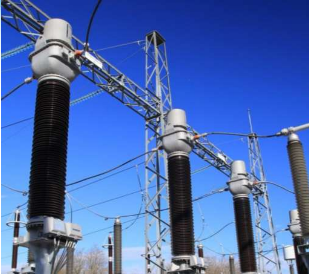
245 kV kombinirani mjerni transformator tip VAU-245
