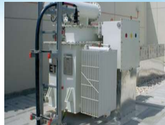
Transformator za uzemljenje 315 kVA, Katar
