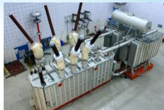
Prijenosni autotransformator 505 MVA 400/132 kV, UAE
