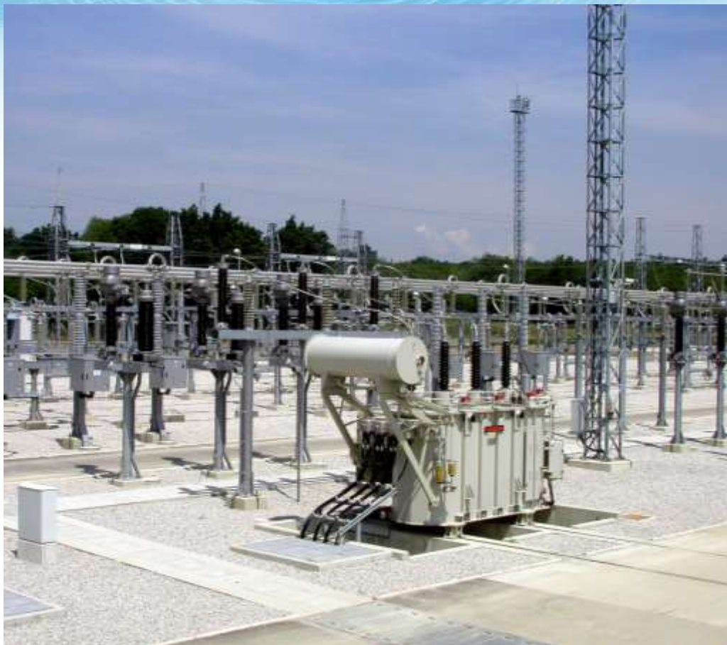
TS ŽERJAVINEC 400/220/110 kV Hrvatska
