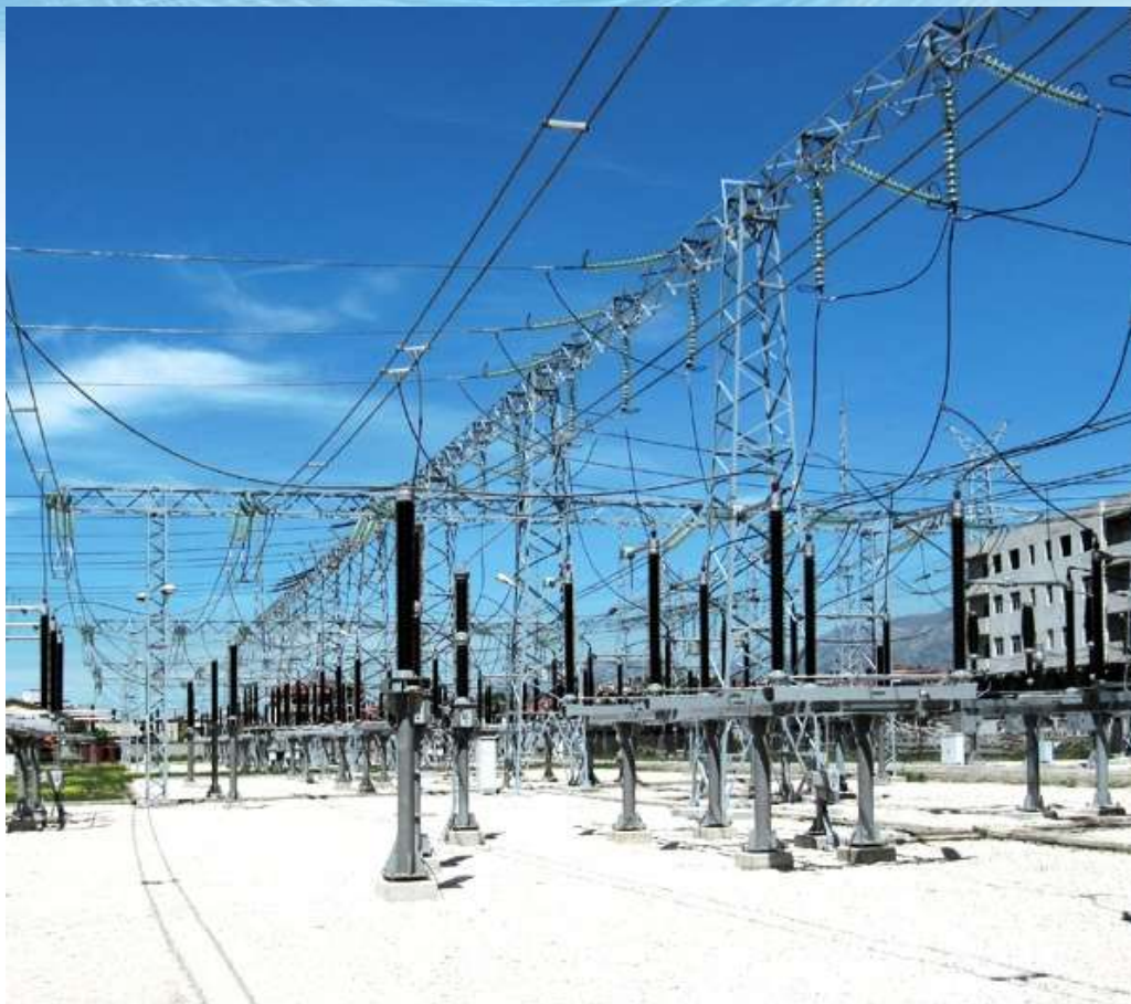
TS TIRANA 1 220/110/35 kV Albanija
